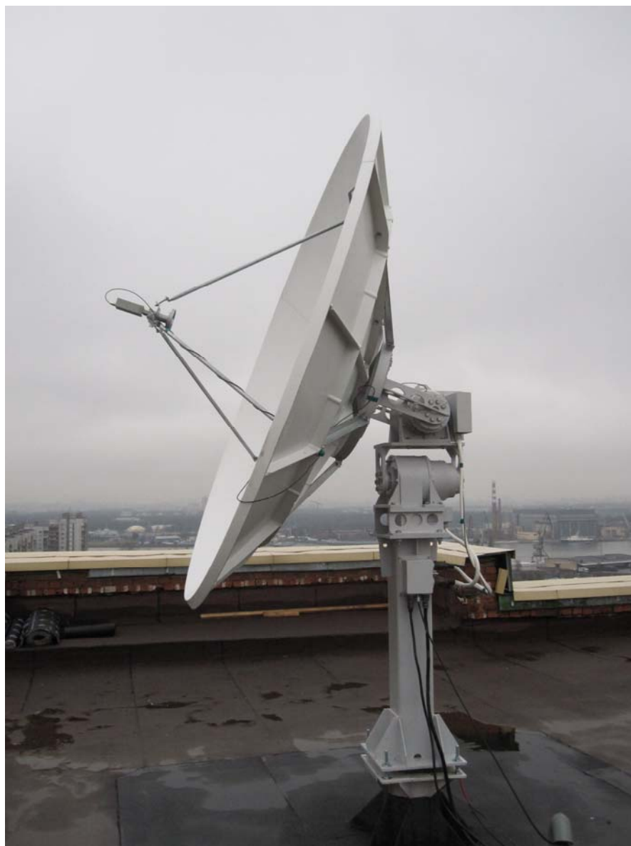
Рис. 2. Земная станция приема и обработки космической информации X-диапазона
